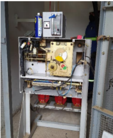
Foto 1 e 2: Disjuntor de média tensão
