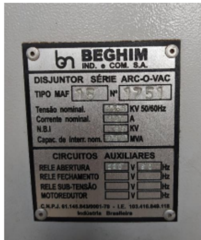
Foto 1 e 2: Disjuntor de média tensão
