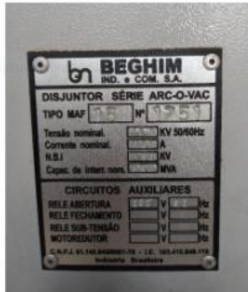
Foto 1 e 2: Disjuntor de média tensão
