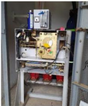
Foto 1 e 2: Disjuntor de média tensão
